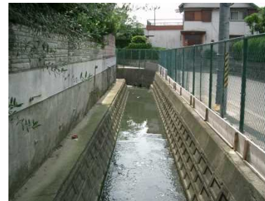
雨水幹線整備前の状況
