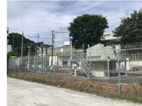
国分市場第1雨水ポンプ場
