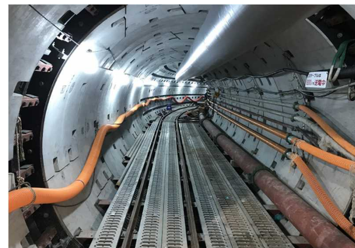
写真：施工状況（上：発進立坑 下：管きょ）
