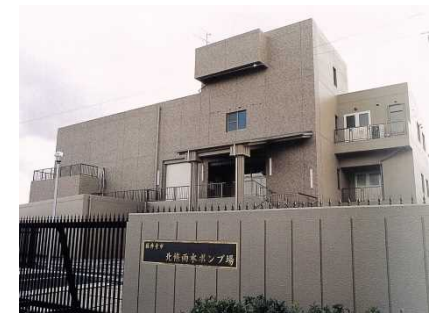
北條雨水ポンプ場
