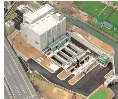
小山雨水ポンプ場
