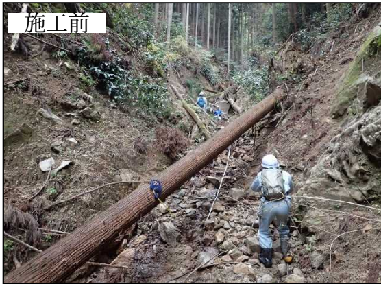
（治山ダム群の整備）
