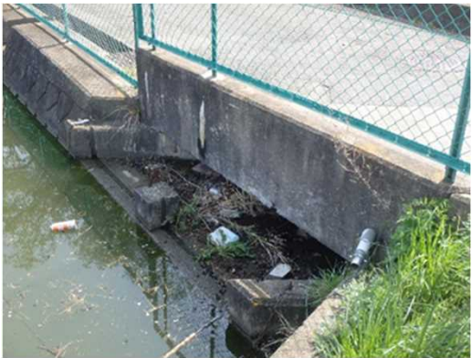
余水吐（着手前）
