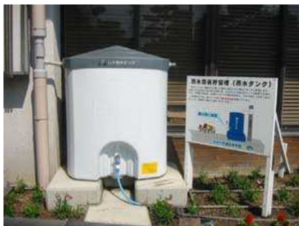
雨水タンク設置状況(市役所前)
