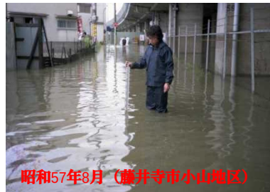
浸水対策前の浸水状況
