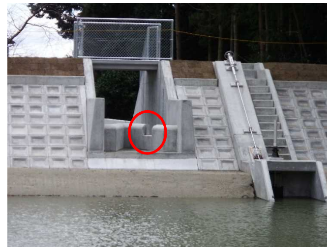
葛城市 大屋下池
