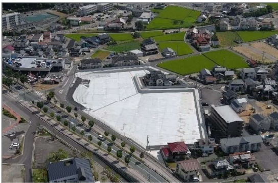
三次市による雨水貯留施設の整備
