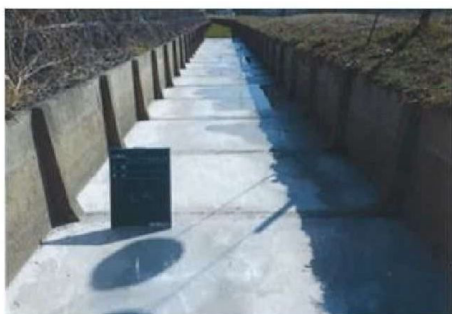
底張コンクリート
