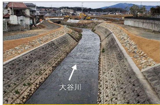
広島県による支川の改修
