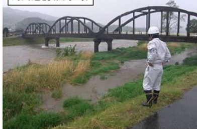
河川巡視(出水時)
