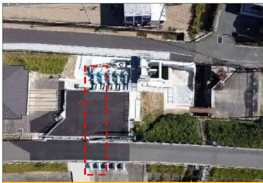
排水ポンプ施設
