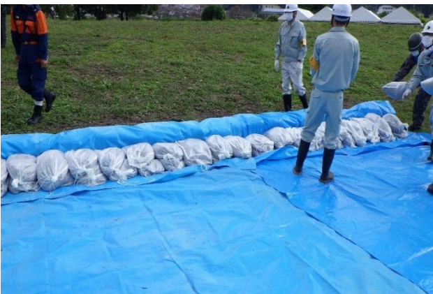
土のう袋積みの様子
