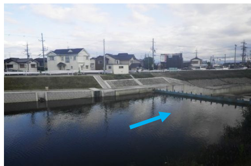
富雄川(護岸改修工事)
