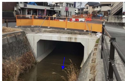
乾川（函渠設置工事）
