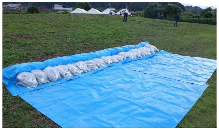
改良土のう工 完成
