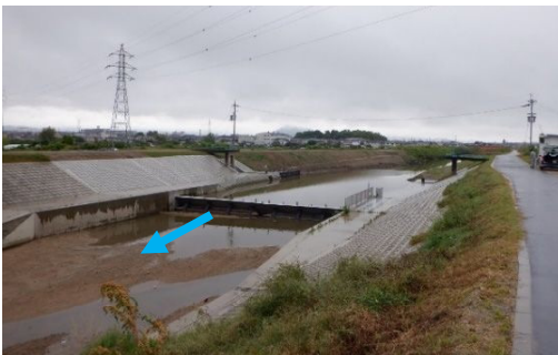
曽我川(護岸改修工事)
