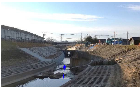
秋篠川（護岸改修工事）
