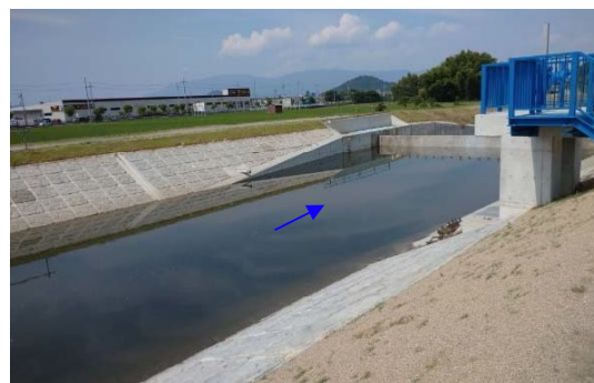
寺川（護岸改修工事）
