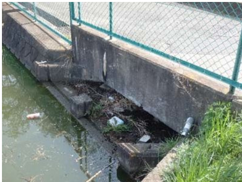
余水吐（着手前）
