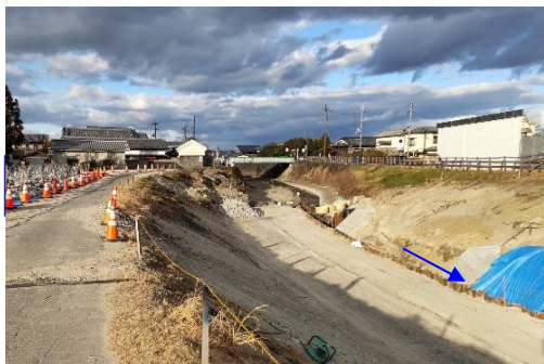
秋篠川(護岸改修工事)
