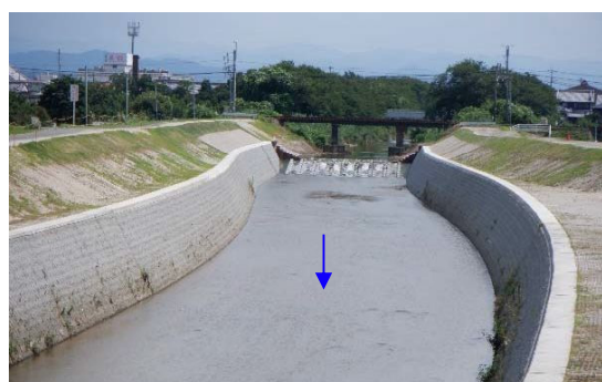
高田川（護岸改修工事）
