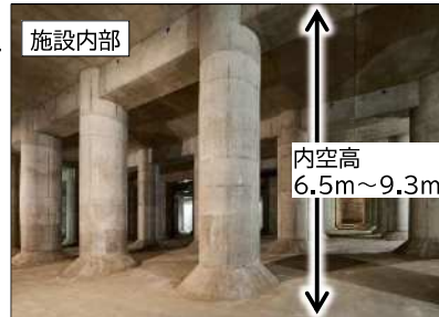
地下貯留施設（三郷町惣持寺調整池）
