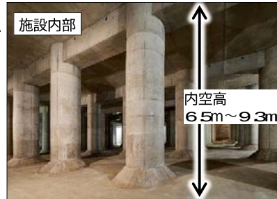
地下貯留施設（三郷町惣持寺調整池）
