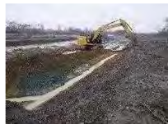
河道掘削 (石狩川水系、北海道開発局)
