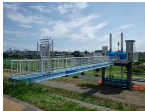
＜樋管全景写真＞
