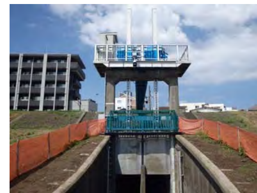
＜樋管ゲート写真＞
