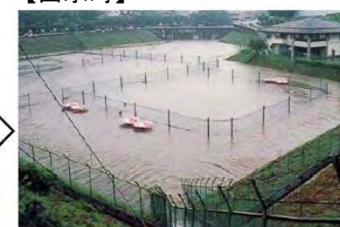
雨水貯留浸透施設の例(防災調整池)
