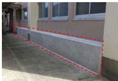
構造体の補強による対策後
