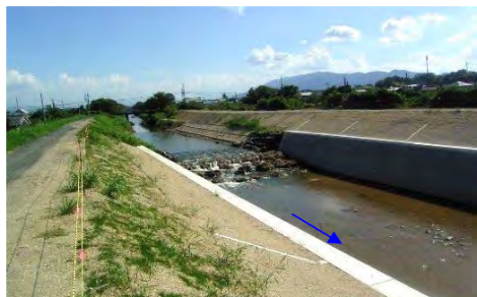
高田川(護岸改修工事)
