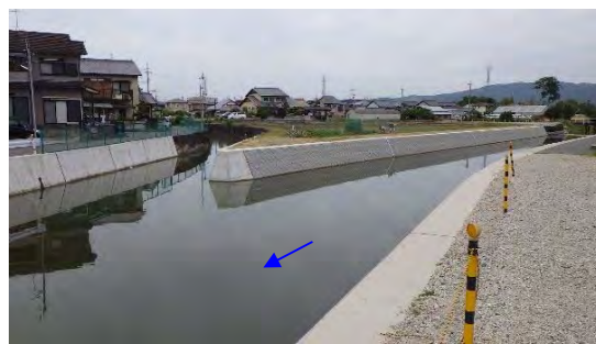
地藏院川(護岸改修工事)
