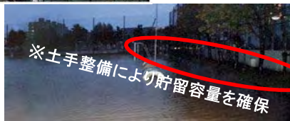
【校庭を活用した貯留施設】
