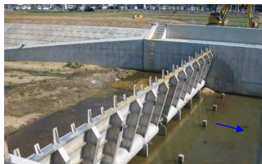
寺川(井堰改修工事)
