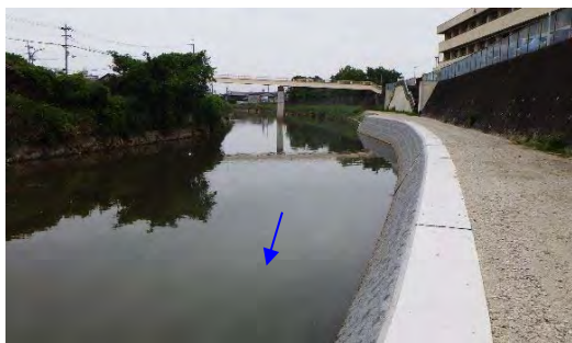
竜田川(護岸改修工事)
