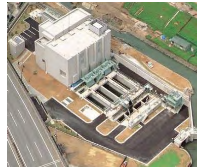
小山雨水ポンプ場
