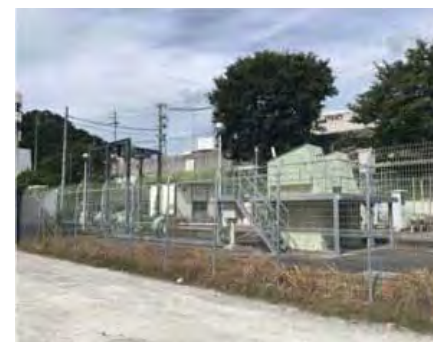
国分市場第1雨水ポンプ場
