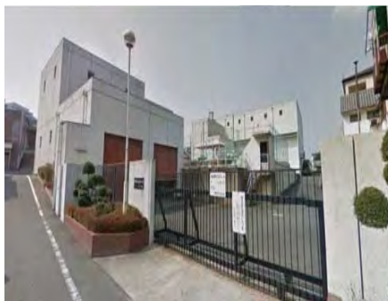
国分第2雨水ポンプ場
