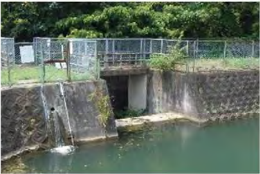
余水吐（着手前）
