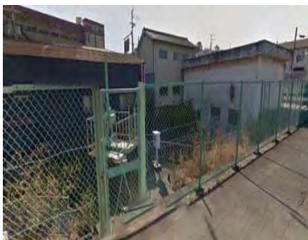
国分第1雨水ポンプ場
