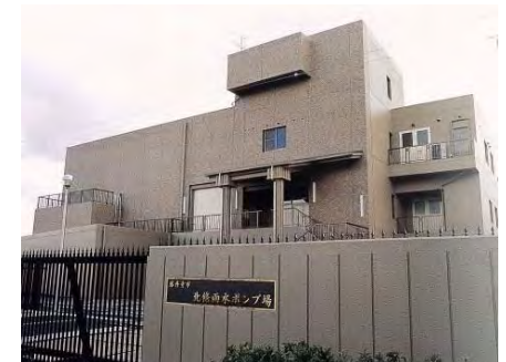
北條雨水ポンプ場
