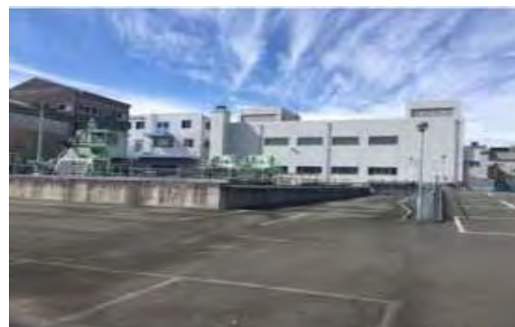
片山雨水ポンプ場
