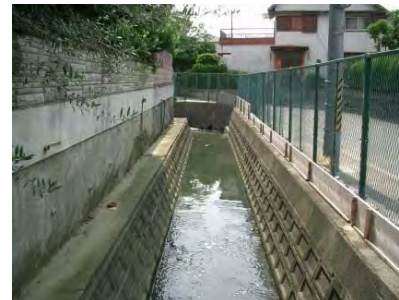
雨水幹線整備前の状況
