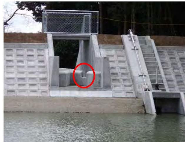
葛城市 大屋下池
