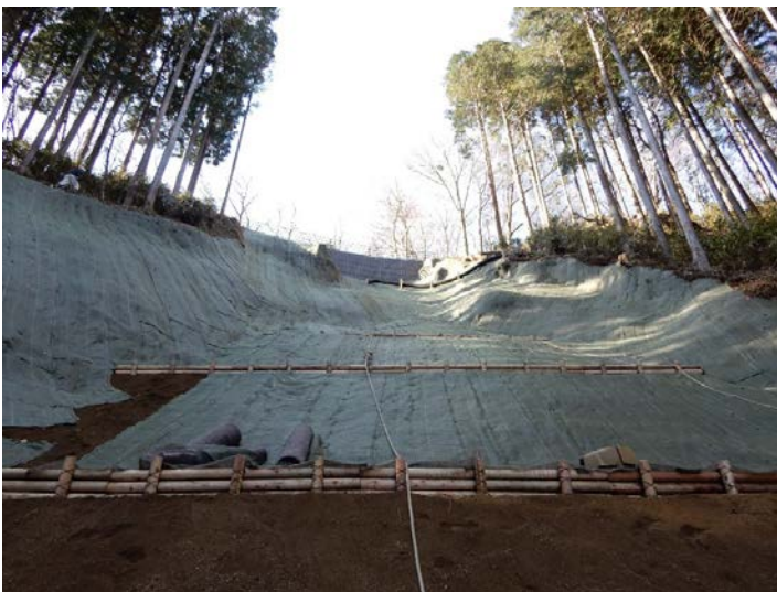
(災害復旧：山腹工)
