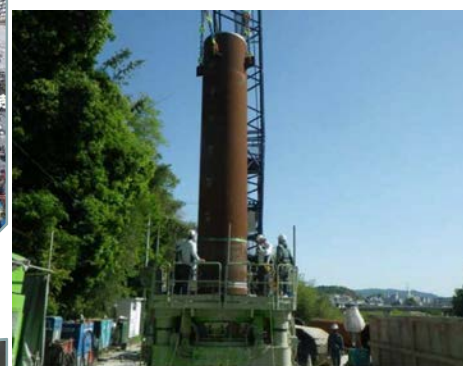
鋼管杭打設状況
