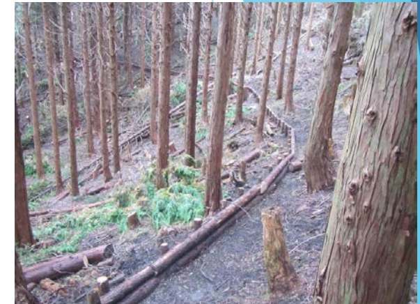
(間伐木を利用した丸太筋工)
