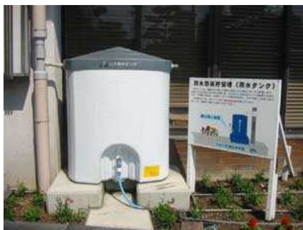
雨水タンク設置状況
