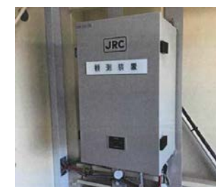
IPテレメータ観測装置設置
