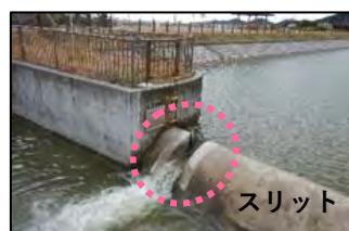
▲スリットの設置状況
