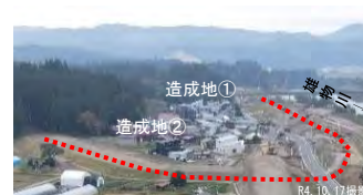
移転家屋の建設が進む状況
