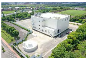
雨水ポンプ場
