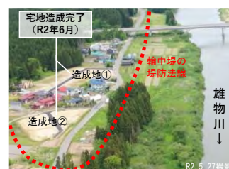
移転先宅地造成完了状況
