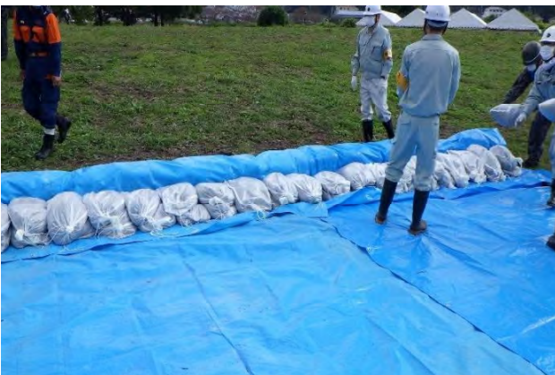
土のう袋積みの様子
