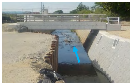
小金打川(護岸改修工事)
