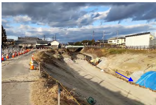
秋篠川(護岸改修工事)
