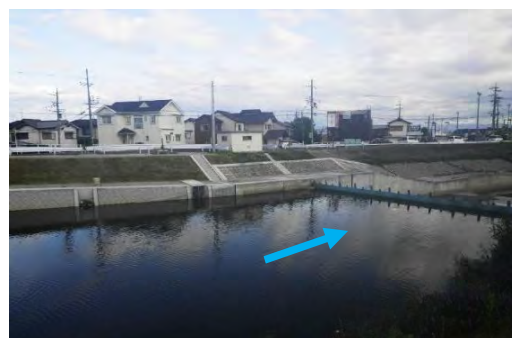
富雄川(護岸改修工事)
