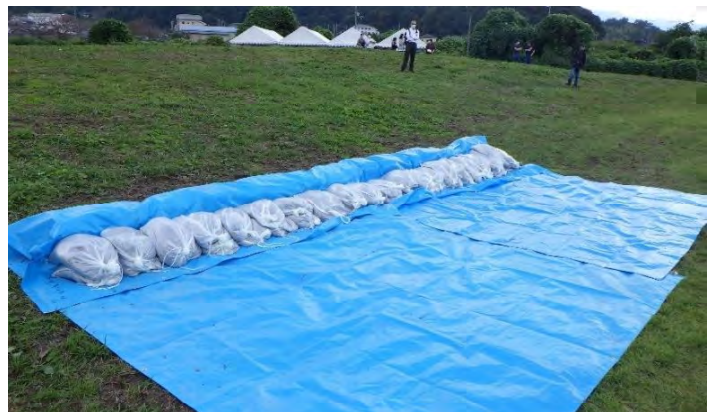
改良土のう工 完成
