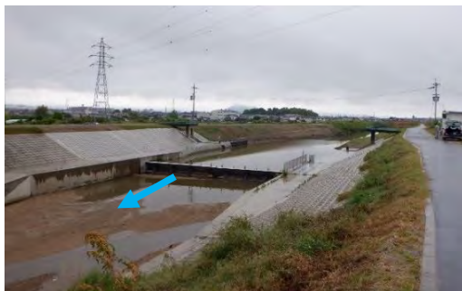
曽我川(護岸改修工事)
