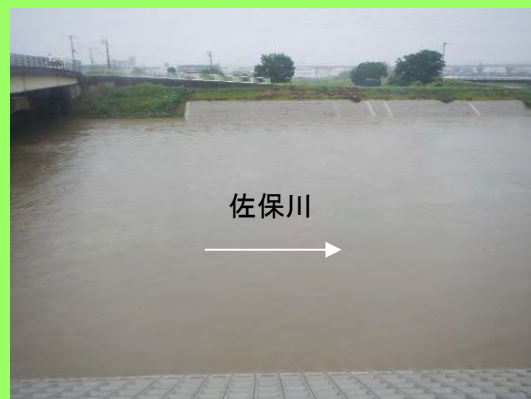
出水時(佐保川旧長安寺井堰周辺)
