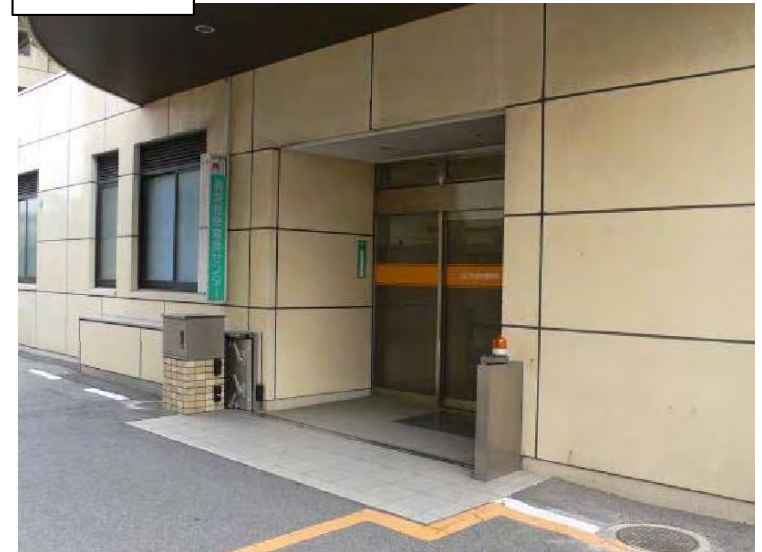
止水板の設置(病院)
