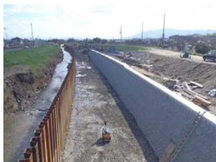
高田川（護岸改修工事）
