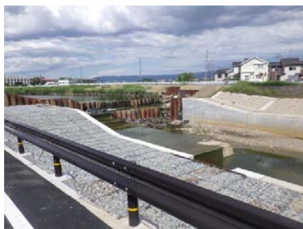
富雄川（井堰改修工事）
