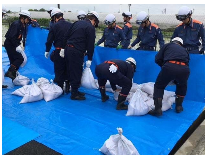
改良積み土のう工法
