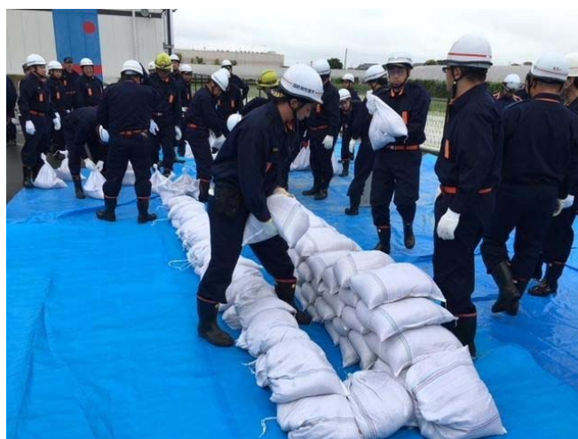
積み土のう工法
