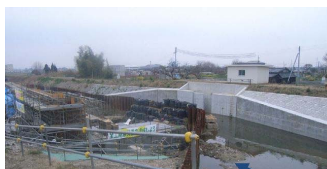
寺川（井堰改修工事）
