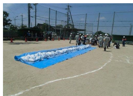
積み土のう設置
