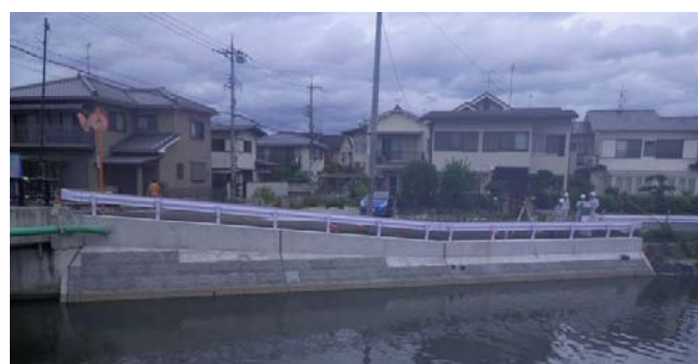
地蔵院川（護岸改修工事）
