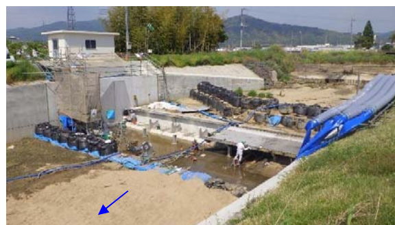
寺川(井堰改修工事)
