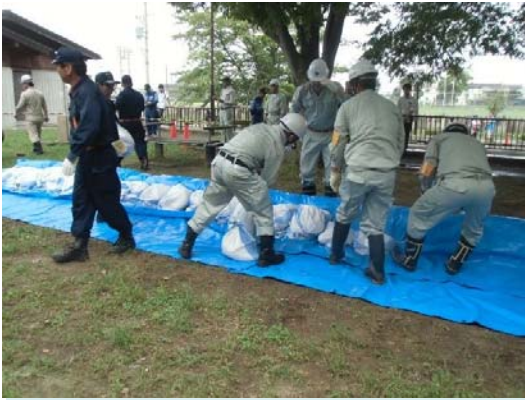
積み土のう設置
