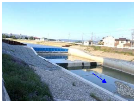
富雄川(井堰改修工事)
