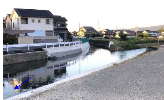
地蔵院川(護岸改修工事)
