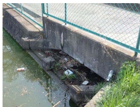
余水吐（着手前）
