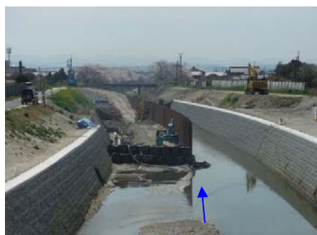
高田川(護岸改修工事)
