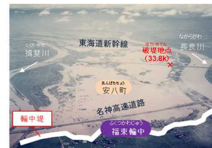
岐阜県輪之内町（福東輪中）
