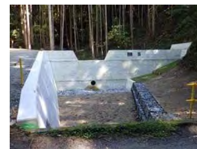
【治山：溪間工（治山ダム）】
