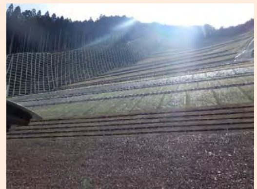
▲【R2.3完成 天川区域 坪内】
