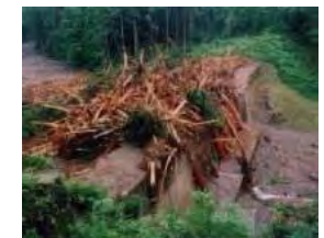
流木捕捉式治山ダム
