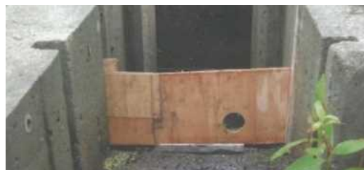
調整板の設置例 (大和郡山市)
