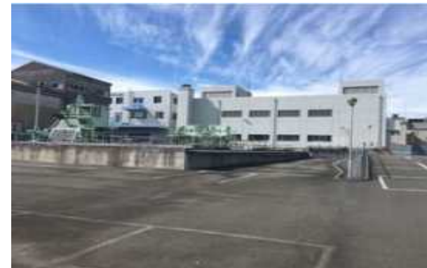
片山雨水ポンプ場
