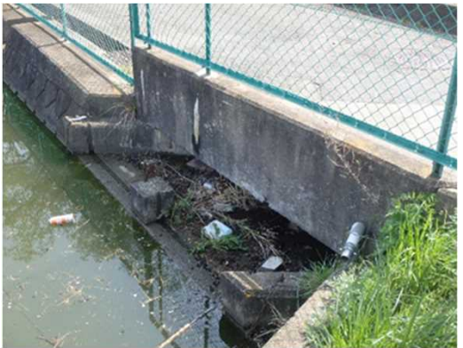
余水吐（着手前）
