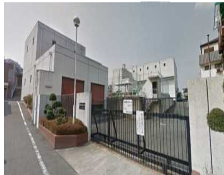
国分第2雨水ポンプ場
