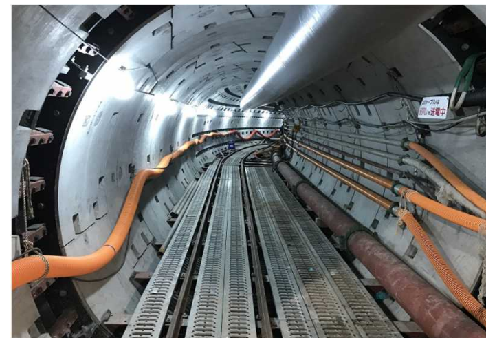
写真：施工状況（上：発進立坑 下：管きょ）
