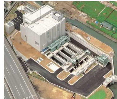
小山雨水ポンプ場
