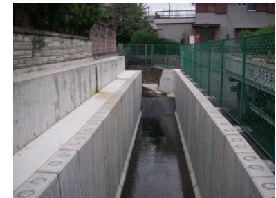
雨水幹線整備後
