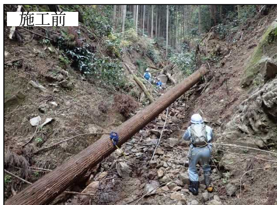
（治山ダム群の整備）
