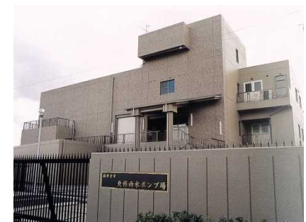
北條雨水ポンプ場
