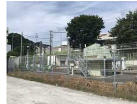
国分市場第1雨水ポンプ場
