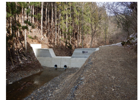
溪間工事の例
