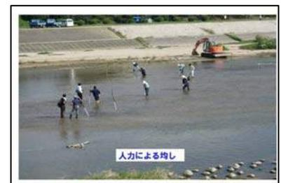
・機械で均したあとは人による敷き均しで、野球のグラウンドで使用するトンボを使用し、最後機械で均しきれないカタピラの跡や産卵場が平らになるよう人力で均していきました。産卵場の造成した範囲は約500m<sup>2</sup>くらいで、去年は造成場所のすぐ上流辺りで、数は少なかったのですが産卵が確認されましたのでその部分を残し、下流で人工の造成をかけました。
