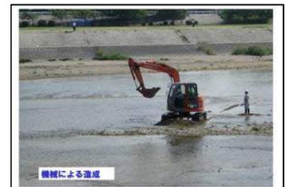
・実施場所は河口から約4.2kmの2号堰堤の下流で昨年度も一部で産卵の実績があった場所の隣接地で計画しました。作業は重機を入れ流れと直角方向に行き来し、石の間にかなだ泥や砂を下流に流しました。この場所には中州があったのですが水量を確保したかったので中州の部分の土の移動をし、造成部分の水を増やすことを検討しました。
