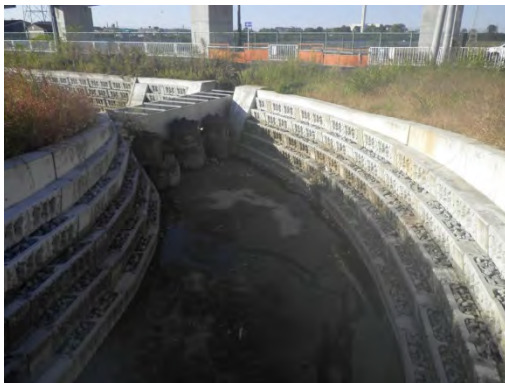
【護岸の整備状況(奈良県、蟹川)】
