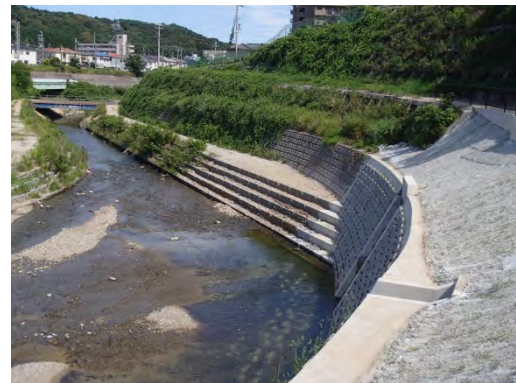
【植栽復旧状況(大阪府、天見川)】
