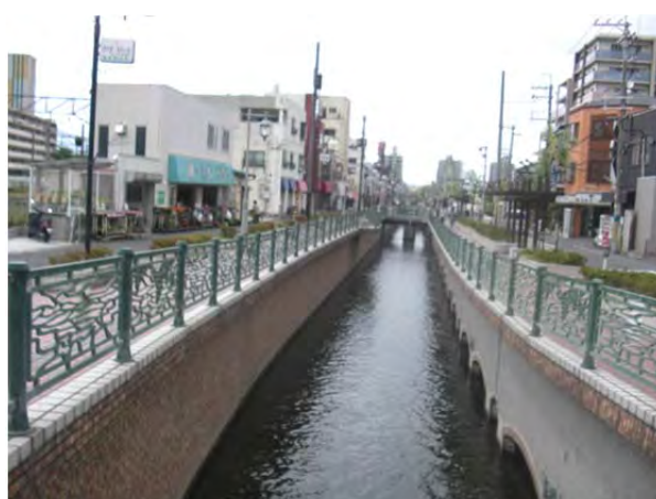
【築留用水路(柏原市)】
