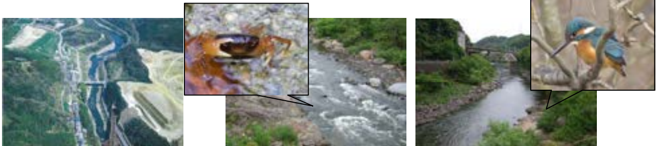
写真 1.28 亀の瀬の状況
