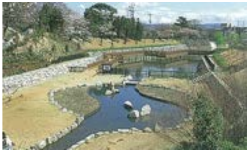
写真 1.18 ため池治水利用施設
