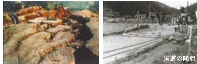
写真 1.24 昭和 42 年の地すべりによる被害
