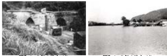
昭和 6～7 年の地すべり （国鉄関西本線の崩壊）
