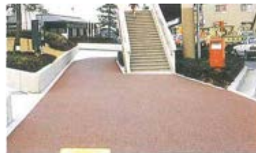
写真 1.21 透水性舗装(斑鳩町役場前)
