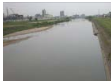
写真 2.8 下流部の単調な景観 (大和川 8.4k 付近)
