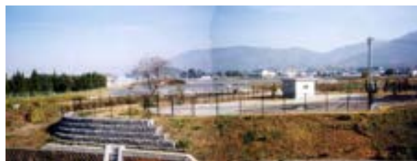
写真 2.15 三輪川浄化施設
