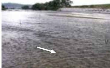
写真2.3 瀬と淵浄化施設により再生された瀬 (大和川15.2k付近)
