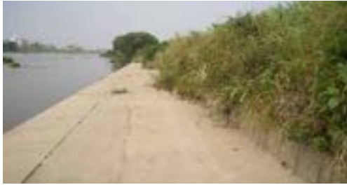
写真2.4 下流部の水際状況 (今井戸川合流部、大和川 7.6k)
