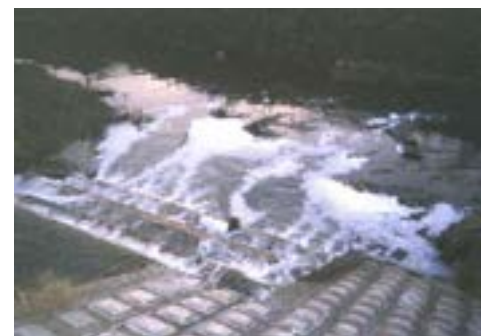
写真 2.14 飛鳥川に排水される濁水
