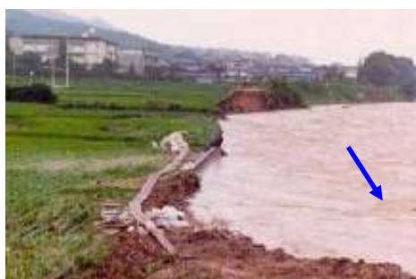
写真 2.22 昭和 57 年 8 月洪水 (石川 昭和橋上流右岸)
