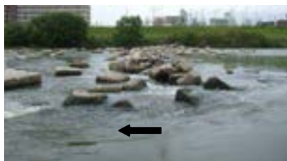
写真4.5 巨石投入による瀬・淵の再生事例 (大和川12.0k下流浄化施設)
