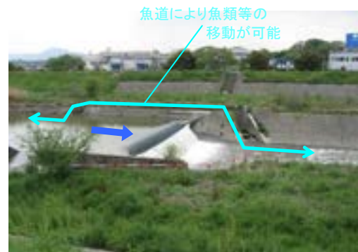
写真4.3 曾我川取水堰の魚道
