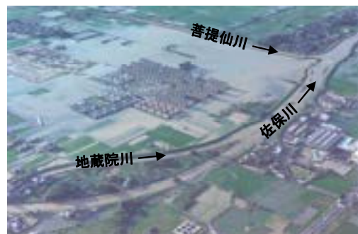
写真4.13 内水被害（佐保川5.2k付近）
