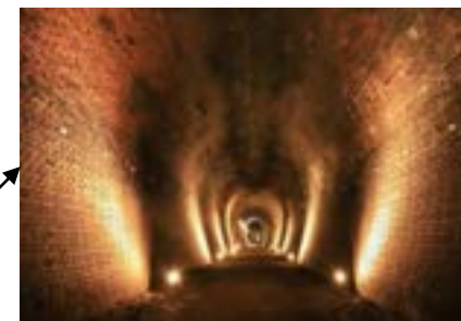
旧大阪鉄道 亀の瀬隧道
