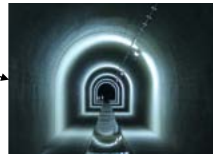
排水トンネル
