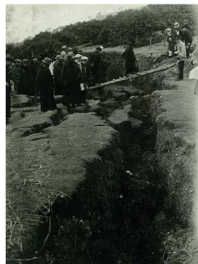
写真 1-1 昭和 6 年 亀の瀬地すべり被害状況
