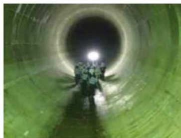
雨水貯留管の整備
