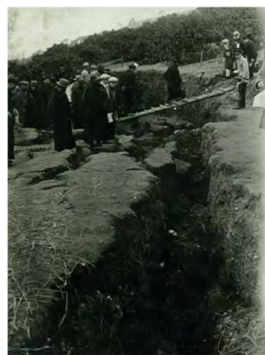
写真 1-1 昭和 6 年 亀の瀬地すべり被害状況
