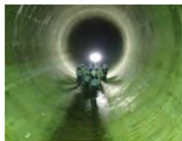
雨水貯留管の整備
