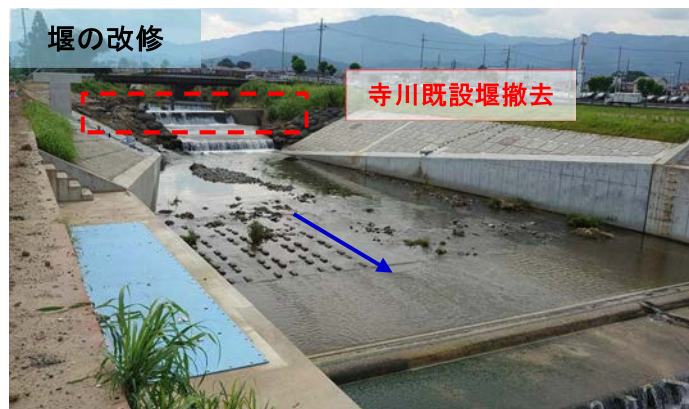
図 4-5 桜井市大福工区佛生井堰（寺川）
