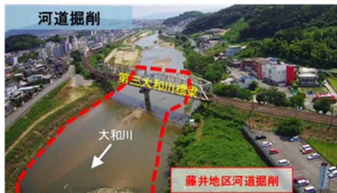
図 4-3 藤井地区河道掘削
