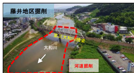
図 2-3 藤井地区掘削
