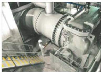
雨水ポンプの整備
