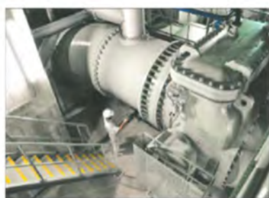
雨水ポンプの整備
