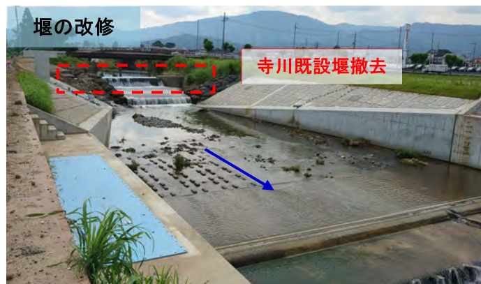
図 4-5 桜井市大福工区佛生井堰（寺川）
