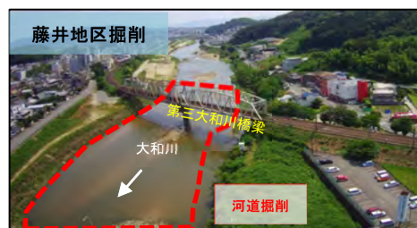
図 2-3 藤井地区掘削
