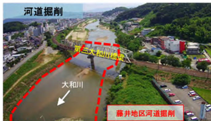
図 4-3 藤井地区河道掘削
