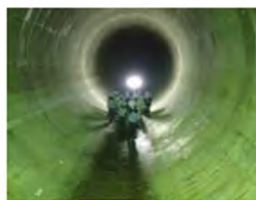
雨水貯留管の整備
