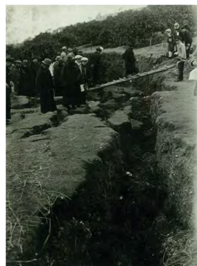
写真 1-1 昭和 6 年 亀の瀬地すべり被害状況
