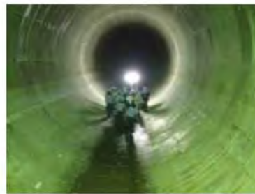
雨水貯留管の整備
