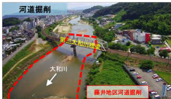
図 4-3 藤井地区河道掘削
