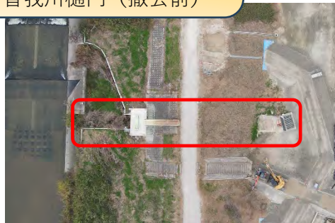
曾我川樋門（撤去前）
