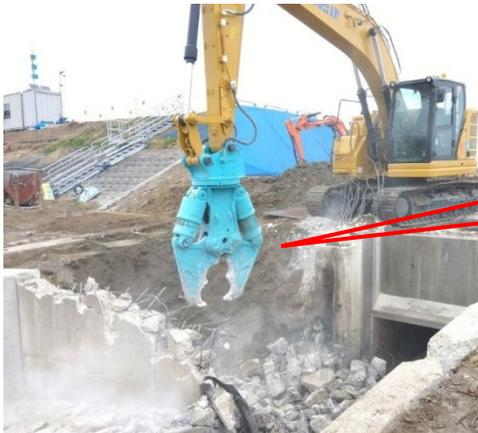
バックホウに**大割機（圧砕機）**を取り付けてコンクリートの解体を行っています！
