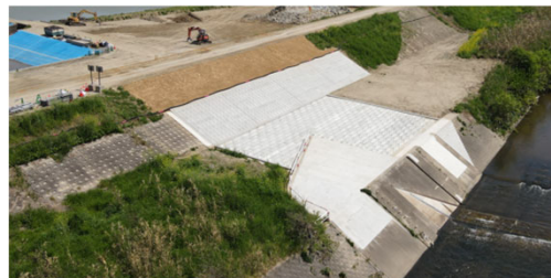
現況写真(R6.4.19撮影)
