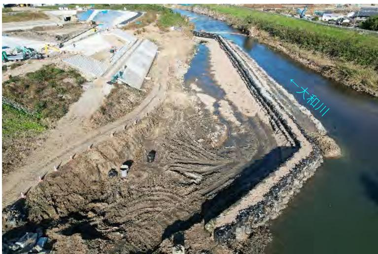
河床掘削後、護床ブロックを敷設します。
