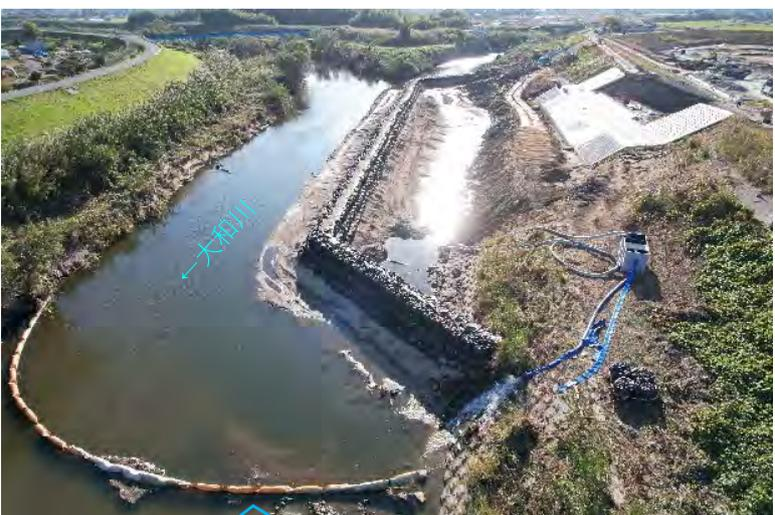
汚濁防止フェンスにより濁水を低減しています。
