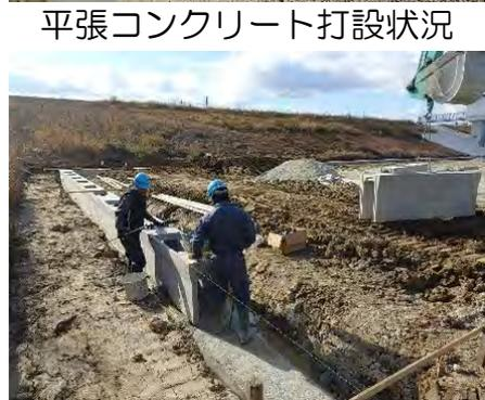
側溝を水平に設置し、内部に流し込むコンクリートで排水勾配を付けます。
