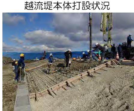
斜面の施工であるため、表面の勾配を一定にするのに手間が掛かります。
