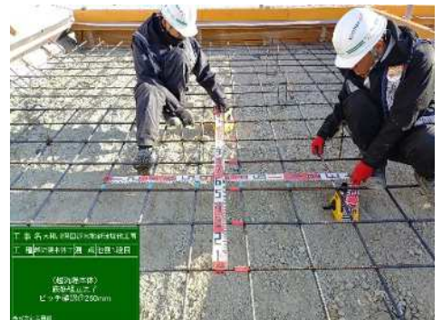
越流堤配筋確認状況
