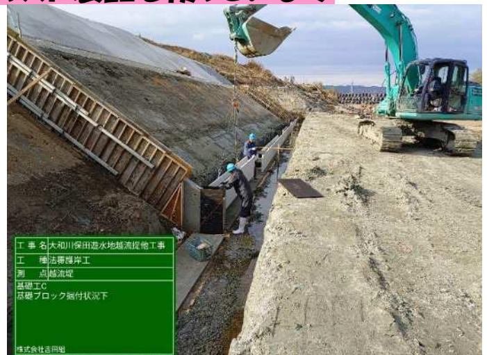
越流堤本体コンクリート打設状況
