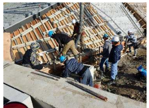
越流堤本体コンクリート打設状況
