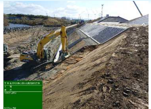
護岸工切土整形状況
