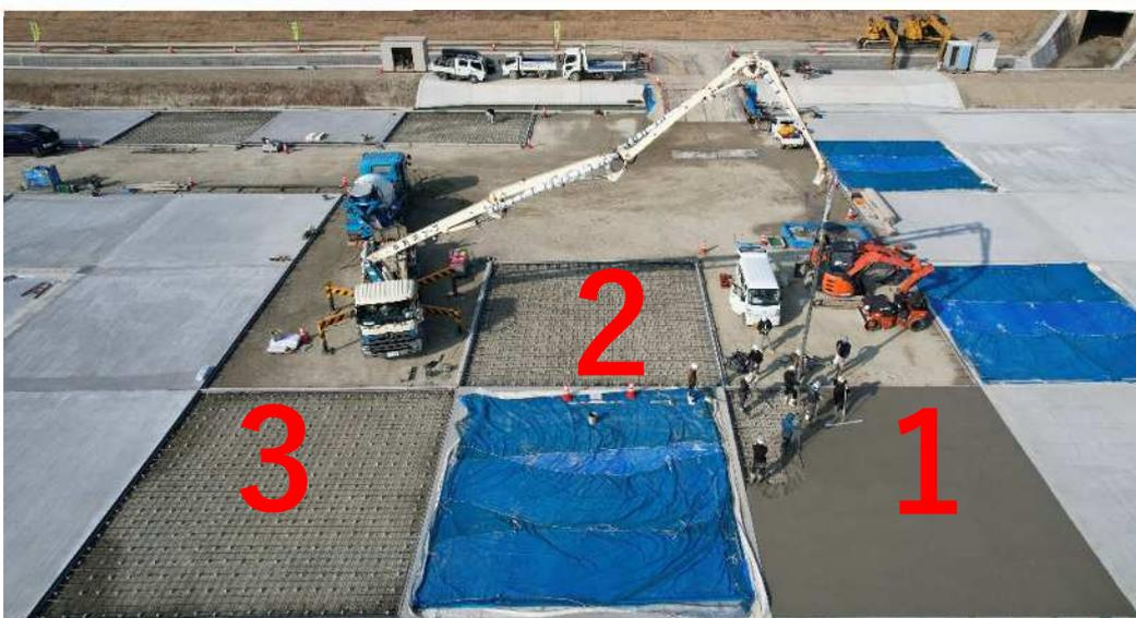
3面で合計100m<sup>2</sup>の施工に対して生コンが45m<sup>3</sup>必要となり、生コン車は12台必要になります。
