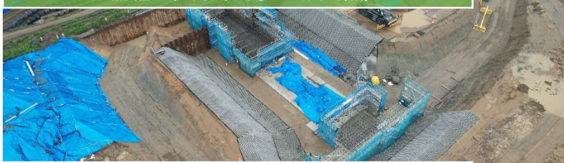
地盤改良・鉄筋組立状況（3月19日時点）
