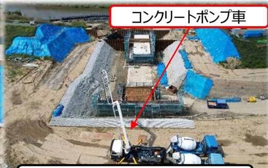
川裏翼壁 コンクリート打設状況
