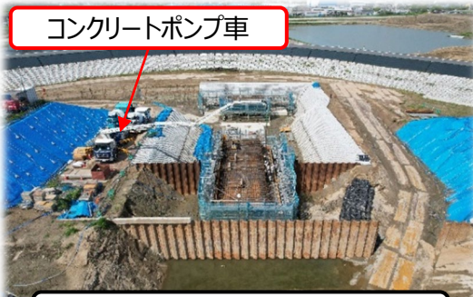
中間スパン コンクリート打設状況
