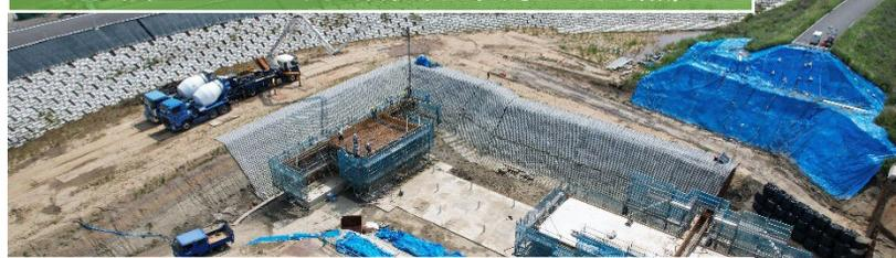
川裏底板コンクリート打設状況（6月11日時点）
