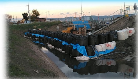
仮締切（岡崎川下流より撮影）
