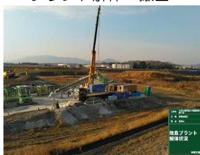
プラント解体・搬出
