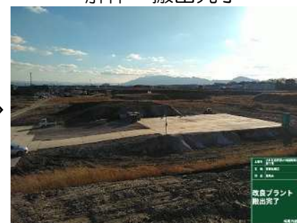
解体・搬出完了
