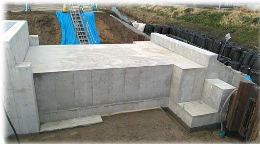
函渠完了（側面）
