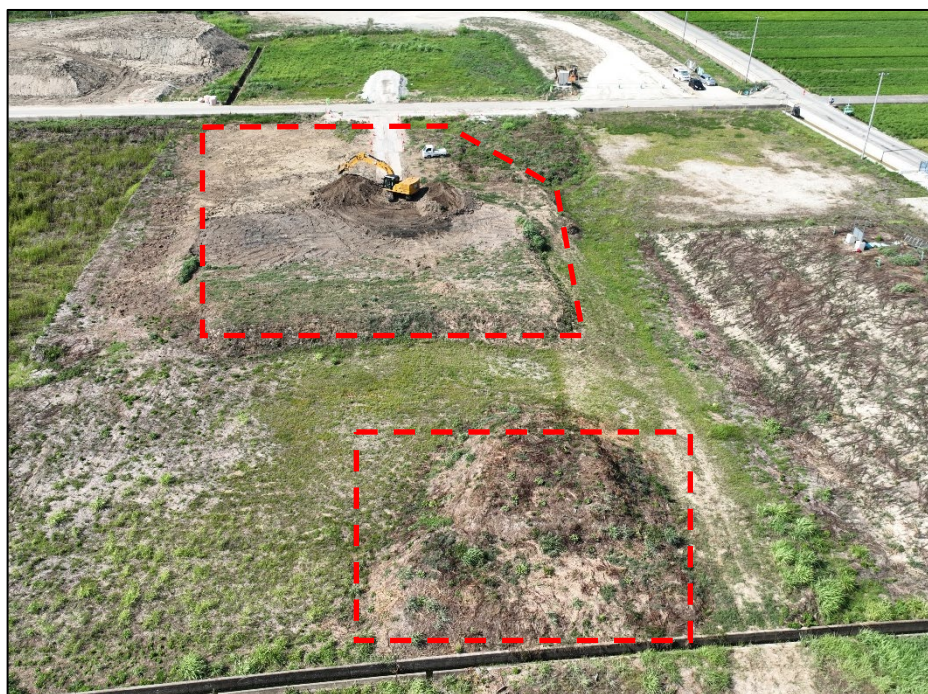
令和7年8月5日撮影 仮置き表土搬出 残土量：約3650m 3
