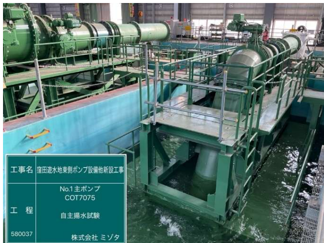
工事名 窪田遊水地東側ポンプ設備他新設工事 工程 No.1主ポンプ COT7075 自主揚水試験 580037 株式会社 ミゾタ
