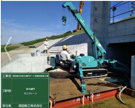
工事名 窪田遊水地排水樋門ゲート設備新設工事 工程内容 排水樋門 カニクレーン 受注者 西田鉄工株式会社
