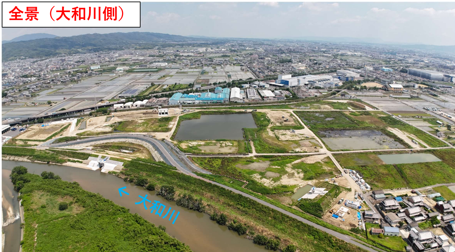
全景（岡崎川側）
