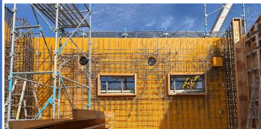
工事名 R7大和川窪田遊水地内水取込樋門 発電機棟他新築工事 工 種 鉄筋工事 測 点 発電機棟 発電機室壁配筋完了 W18 2024/09/04
