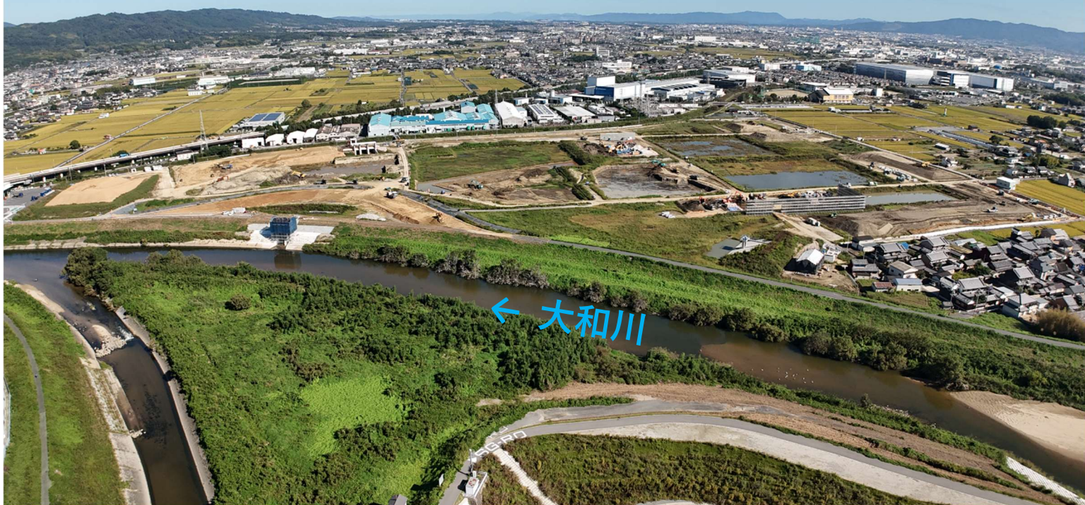
全景（岡崎川側）
