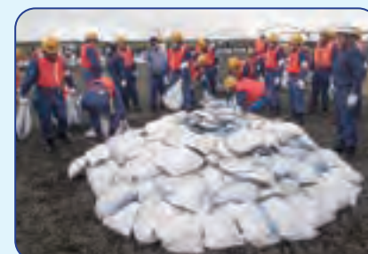
③ 固めた間詰め土の上に土のうを積み上げる
