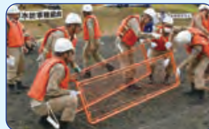
① 鋼製の枠を設置する
