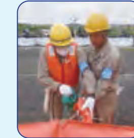
② 給水口から水を注入 ※訓練のため代わりに空気を入れる
