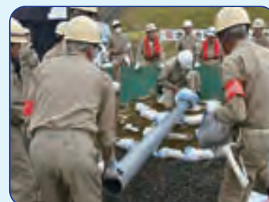
④ 排水パイプを取り付ける
