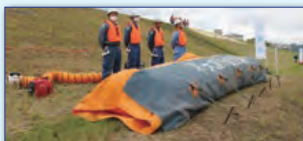
① 給水口から水を注入 ※訓練のため代わりに空気を入れる
