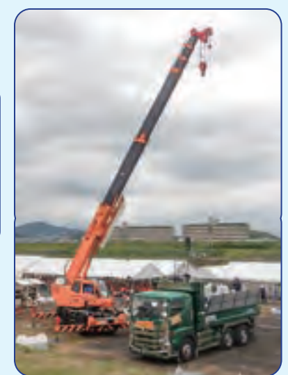
クレーンで根固めブロック吊り上げ
