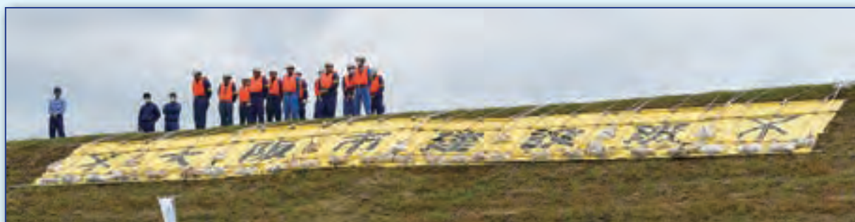
⑤ 土のうで斜面にシートを固定する
