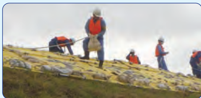
⑤ 土のうで斜面にシートを固定する
