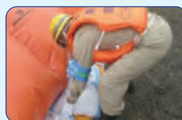
④ 押え土のうを設置する
