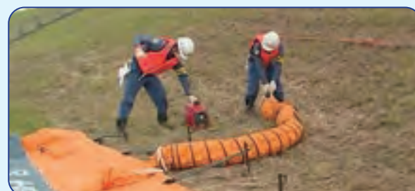
① 給水口から水を注入 ※訓練のため代わりに空気を入れる
