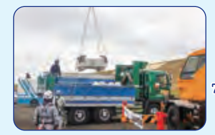
クレーンで根固めブロック吊り上げ
