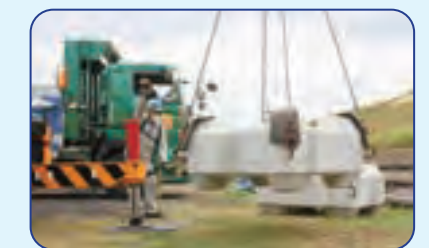
根固めブロック設置の様子
