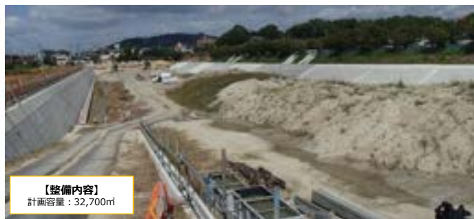
王寺町 葛下流域貯留施設（工事中）
