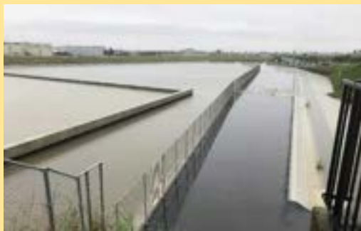
【川西町 唐院工業団地調整池】 約40000m³を貯留し、周辺の浸水被害を回避
