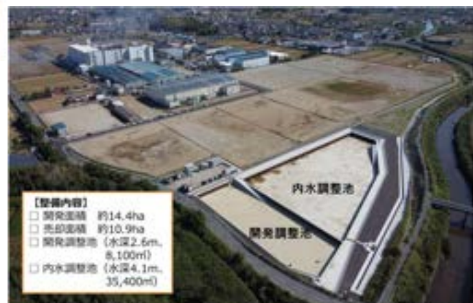
川西町 唐院工業団地調整池（令和4年度完成）
